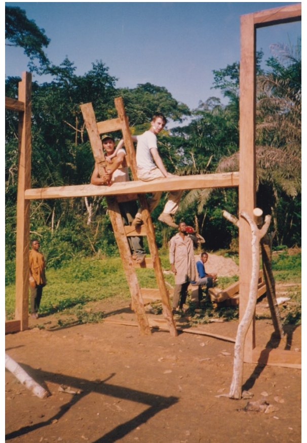
Gilles et Mickaël récupèrent après avoir levé la charpente (1993)
