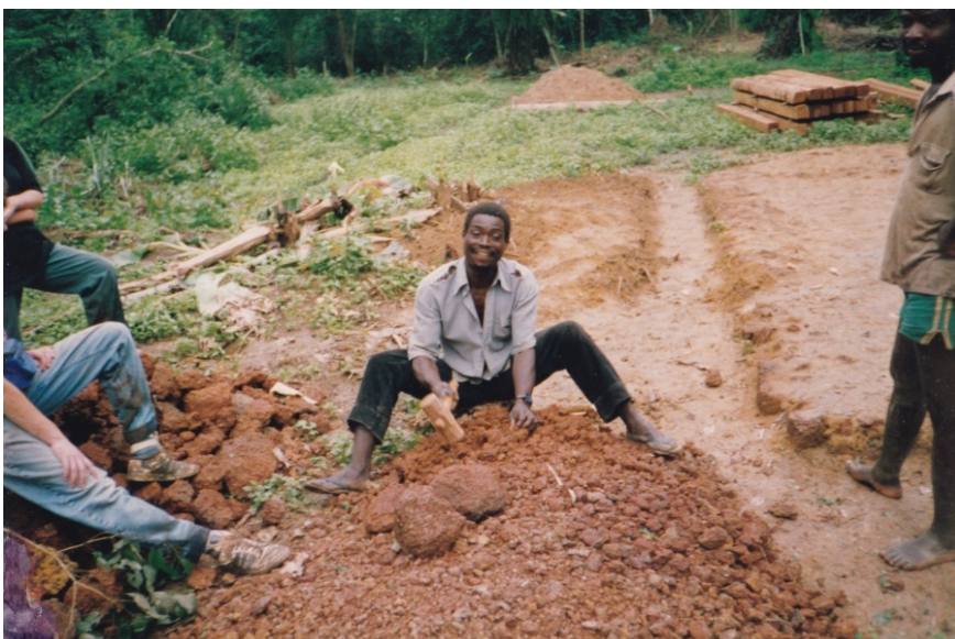
Desiré travaille sur les fondations (1993)
