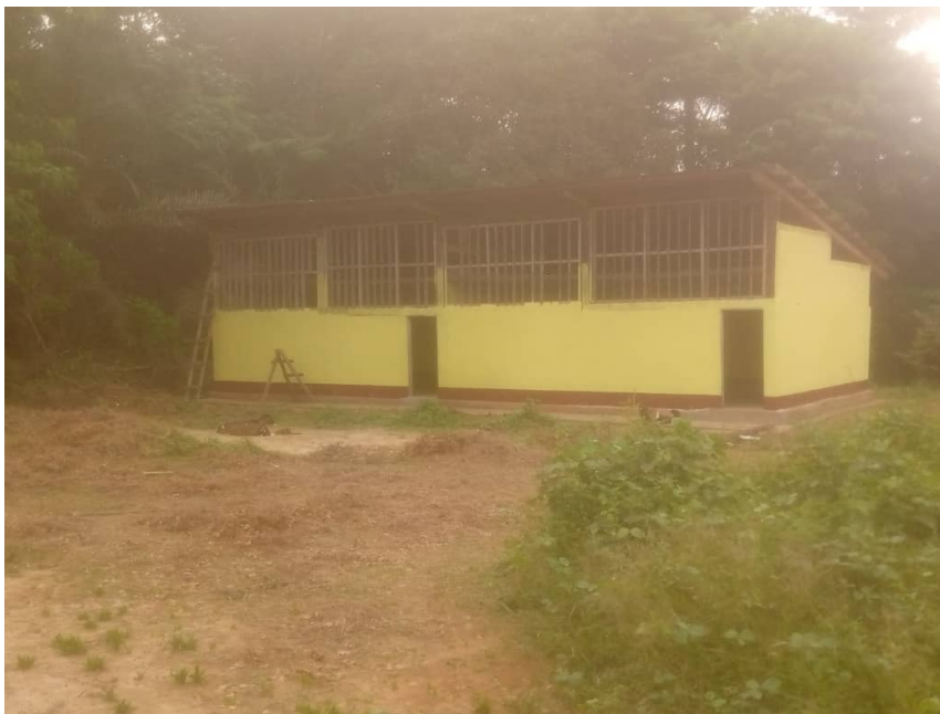
L'école Erwan Huard en cours de rénovation (juin 2025)
